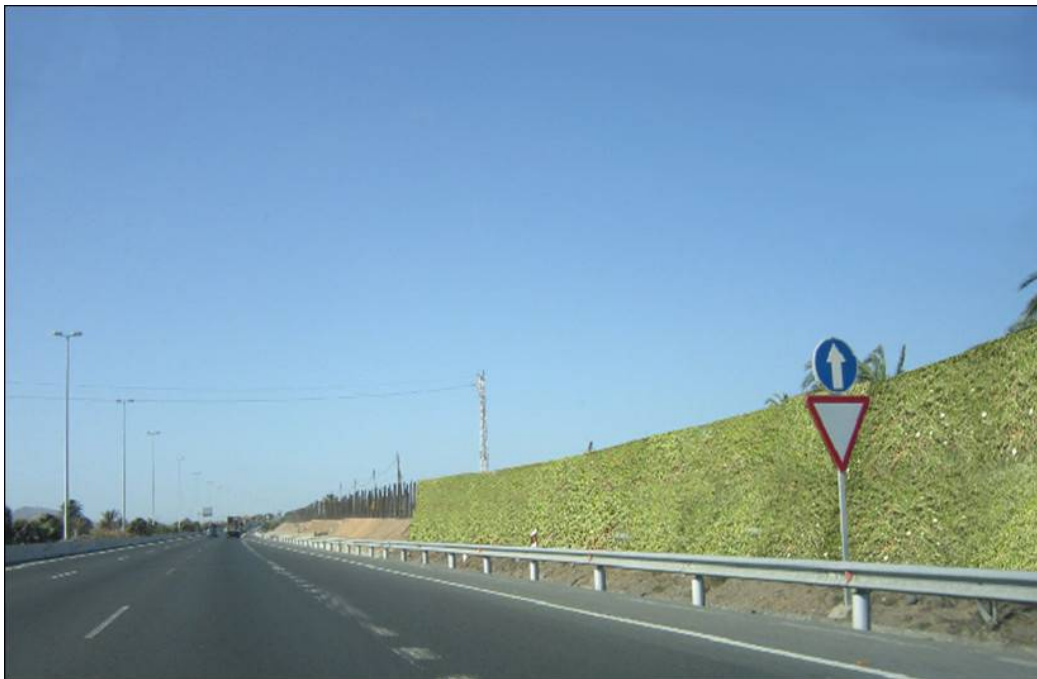
Nuevas pantallas acústicas vegetales instaladas en una autovía de Las Palmas de Gran Canaria. / UPM
