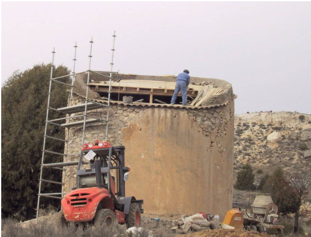
Obras de rehabilitación de un antiguo palomar en la provincia de Soria. Fuente: UPM.
