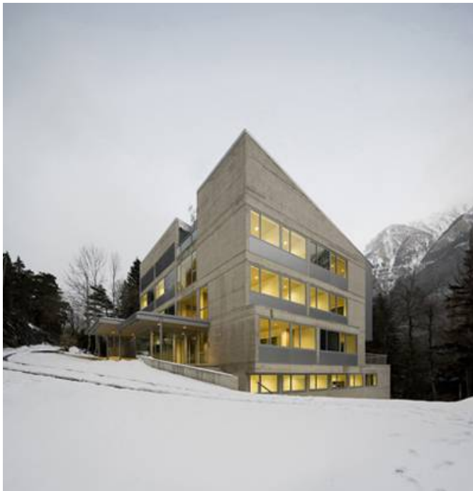
Sede del Laboratorio Subterráneo de Canfranc.
