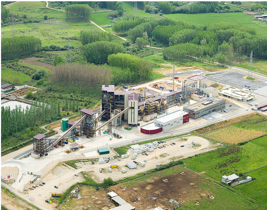
Instalaciones en Cubillos del Sil. Imagen: CIUDEN.
